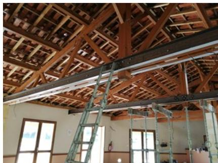
*poutres en fer posées par une grue sont venues rehausser la charpente de plusieurs centimètres.*
